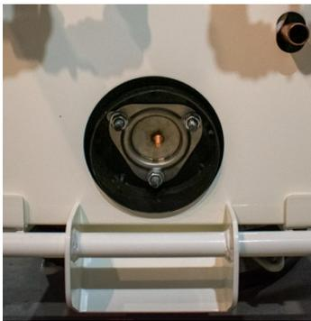
Unter dem Gerät befindet sich eine Wartungsöffnung, nach deren Öffnung Sie mit einem am KFE-Hahn des Rücklaufes angeschlossenen Schlauch Rostschlamm aus dem Boiler herauspülen können. **Verbinden Sie dabei Vor- und Rücklauf mit einem Schlauch oder verschließen Sie sie mit Kappen.**
